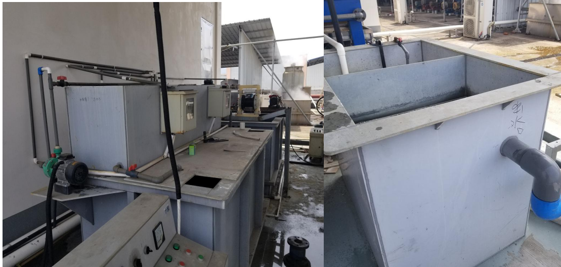
图 5-1 污水站现场图
